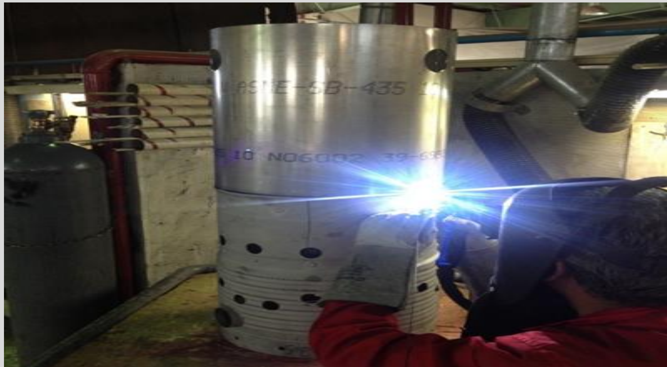
شکل ۴) اتصال قسمت میانی ساخته شده به لاینر
